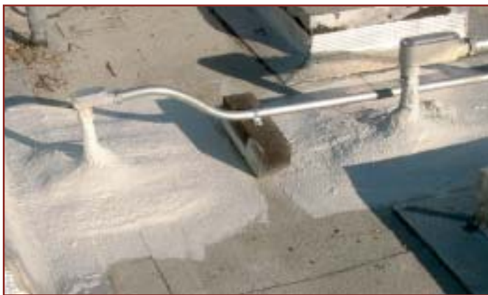
New conduit penetrations.
