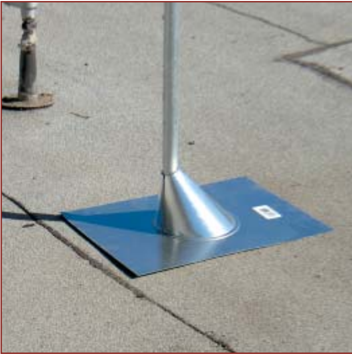
New conduit penetrations.
